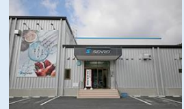
水産加工工場外観 (女川町)
