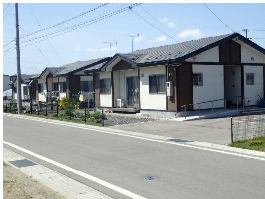
災害公営住宅（区画整理区域内）
