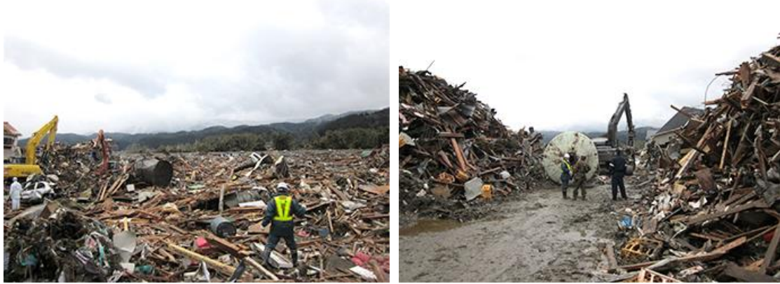
写真1：陸前高田市内の道路啓開（左：啓開前、右：啓開後）（出典：国土交通省 東北地方整備局）
