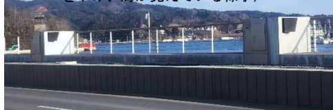
魚町 写真提供：気仙沼市（*フラップゲートを下げ、海が見えている様子）
