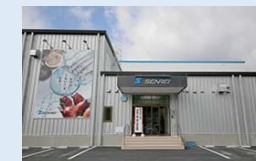
水産加工場外観 (女川町)
