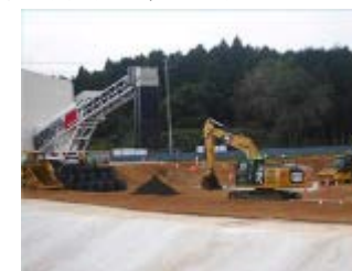
中間貯蔵施設
