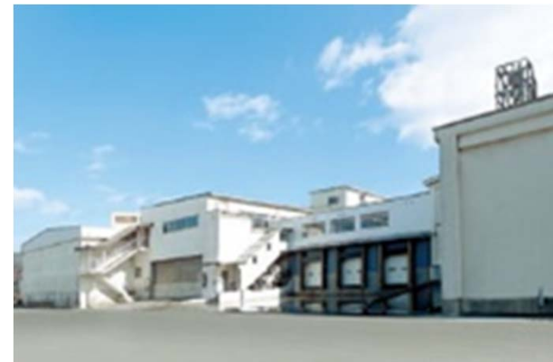
(参考2)活用事例(水産加工場等の復旧・新設)
