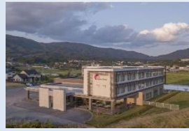
宿泊施設外観 (陸前高田市)
