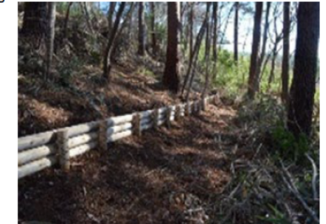
例：丸太筋工
