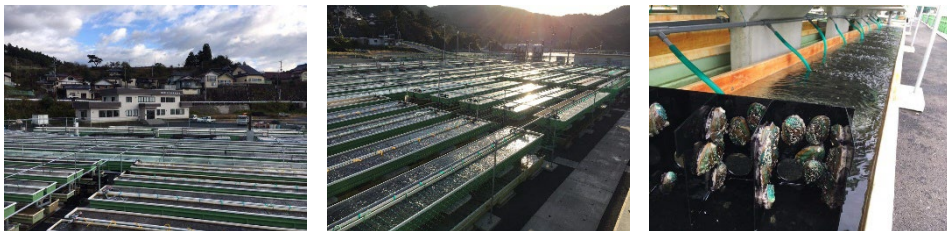
< グループ補助金の活用により再建されたアワビ養殖施設 >
