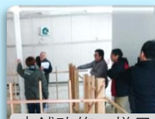
店舗改修の様子
