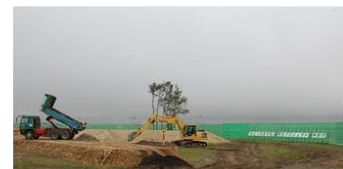
植生基盤の復旧
