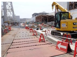
フェーシング前 (3号機付近)
