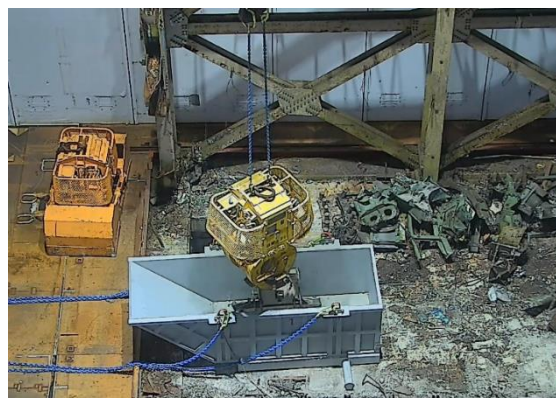
ガレキ撤去の様子
