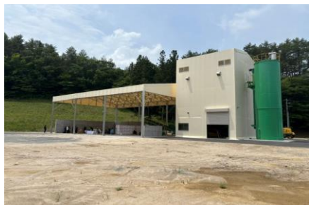
東部産業団地での操業施設
