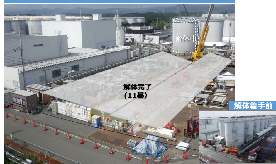
タンクの解体状況
