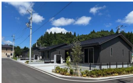
（葛尾村再生賃貸住宅）
