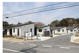
津島地区再生賃貸住宅
