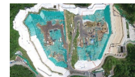
特定廃棄物埋立処分場
