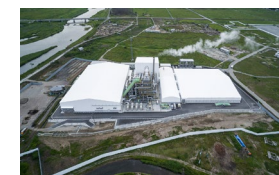
浪江町 仮設焼却施設
