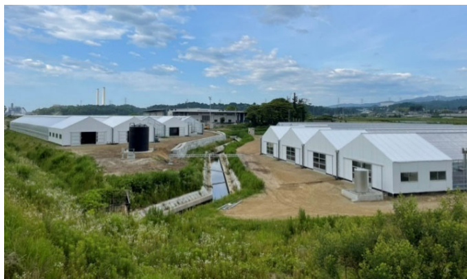
完成したかんしよの高品質苗の供給施設（楡葉町）
