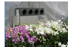
ヒートポンプ（空気熱源）
