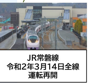
JR常磐線 令和2年3月14日全線 運転再開
