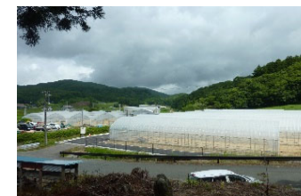
整備された水稻育苗施設
