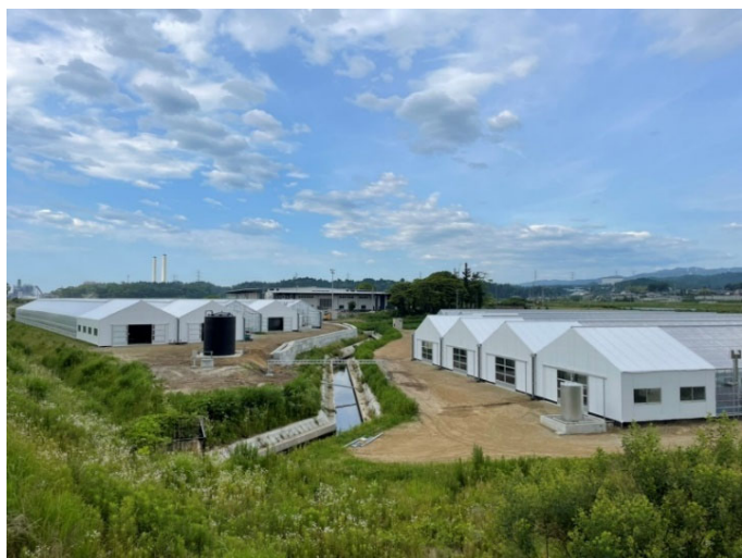
完成したかんしょの高品質苗の供給施設（楢葉町）
