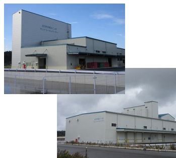
令和3年度に整備したカントリーエレベーター2基
