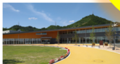
大熊町役場庁舎への太陽光発電システムの導入
