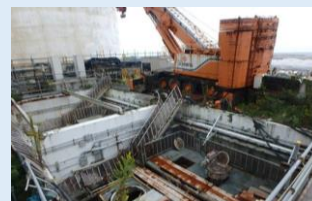
4号機 タービン建屋海側 フェーシング施工
