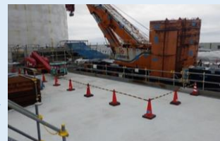
4号機 タービン建屋海側 フェーシング施工
