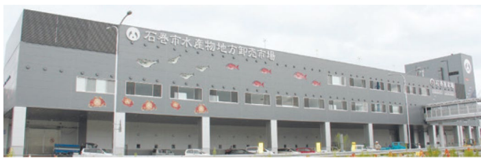
石巻魚市場（平成27年9月完成）
