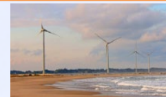
万葉の里風力発電所 (南相馬市)
