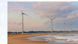
万葉の里風力発電所（南相馬市）
