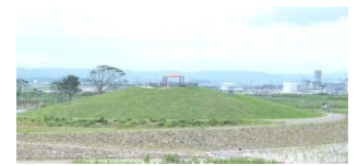
(防災公園(岩沼市))
