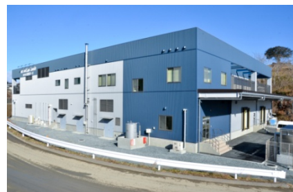
竣工した陸前高田新工場
