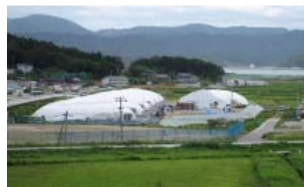
稼働した植物工場
