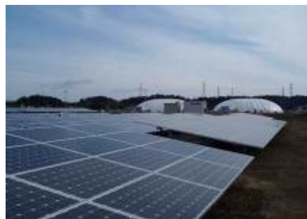
太陽光発電所（平成25年3月）
