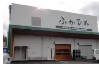
高台に完成した新工場
