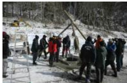
井戸復元作業（平成25年2月）
