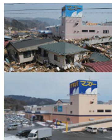
被災後の施設外観 （上段：H23.3、下段：H23.12）
