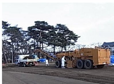
グラウンド: 表土の剥ぎ取り
