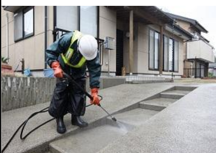
コンクリート土間：高圧水洗浄
