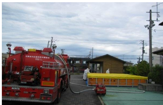
防火水槽の増設
