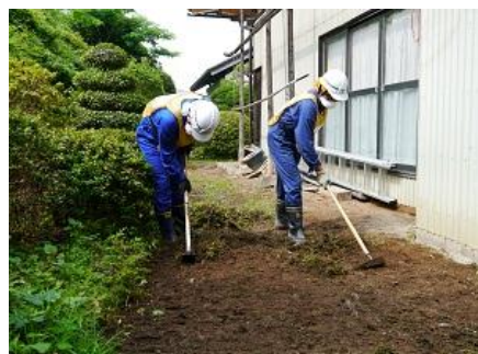
庭：表土の剥ぎ取り
