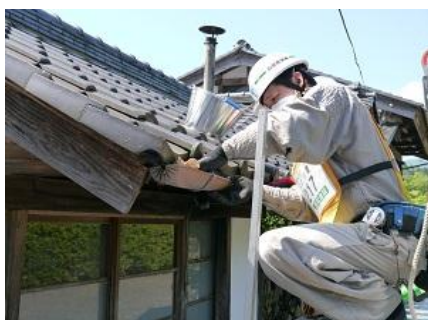
雨樋：拭き取り
