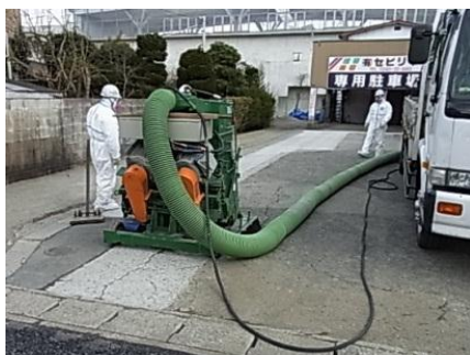
コンクリート土間：ショットブラスト
