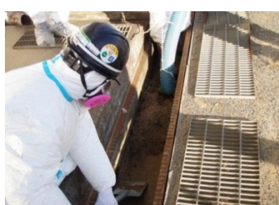
側溝: 堆積物除去
