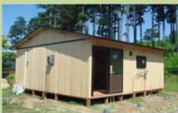
陸前高田市・住田町の仮設住宅
