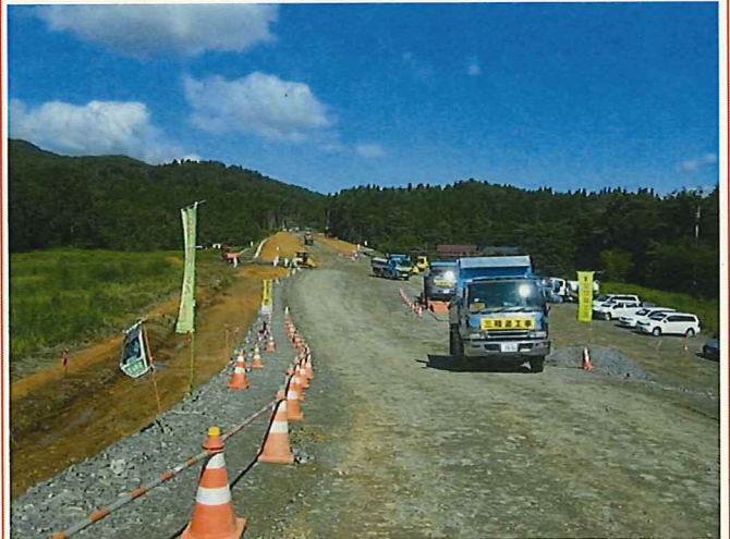
気仙沼市本吉町道貫岩尻地区の工事風景
