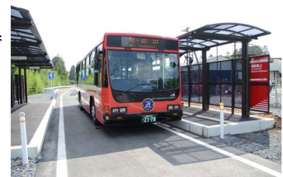
【BRT運行の様子】
