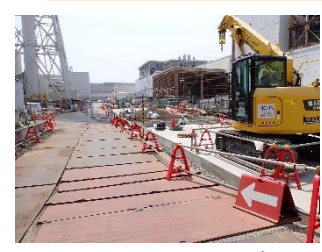
フェーシング前 (3号機付近)
