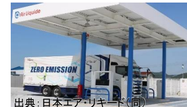
本宮インターチェンジ水素ステーション
