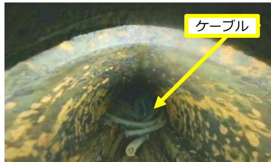
①PCV貫通部(X-6ペネ)内の様子
