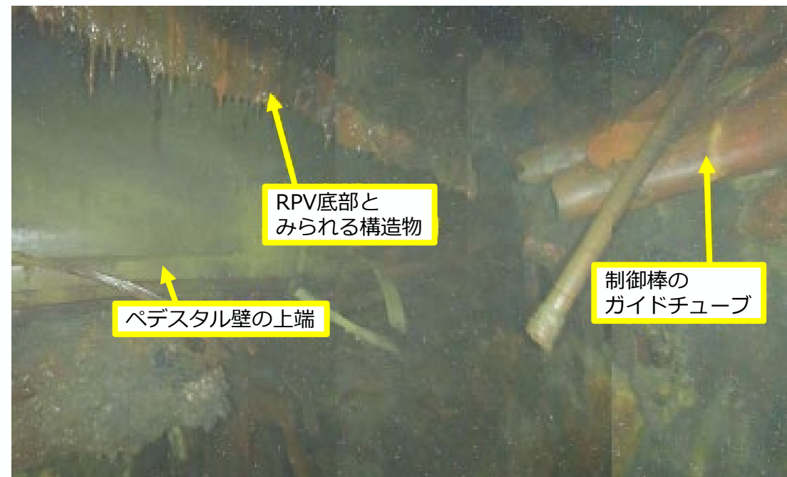
②RPV底部付近の様子
