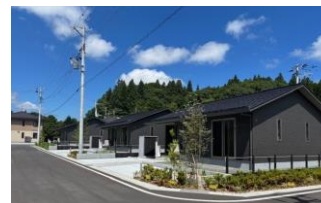
葛尾村再生賃貸住宅
