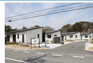
津島地区再生賃貸住宅
