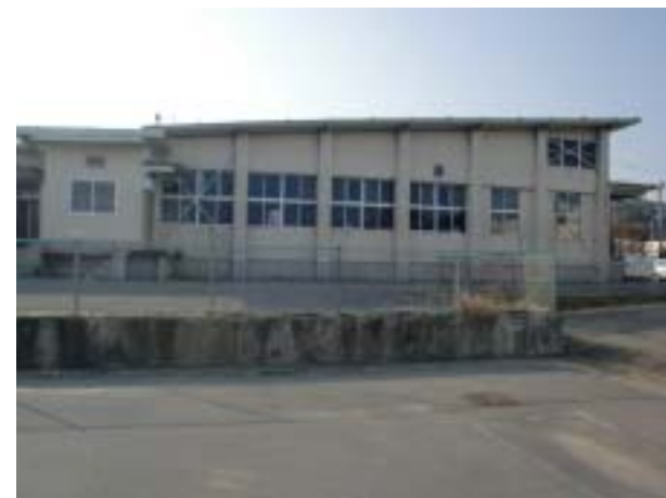
敷地東側の様子
