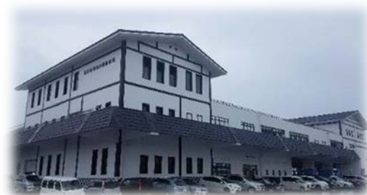
原釜荷捌き施設(相馬市)
