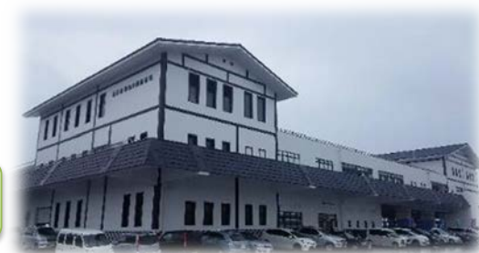
原釜荷捌き施設(相馬市)
