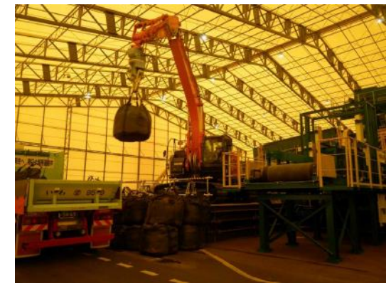
受入・分別施設（1期双葉工区）
