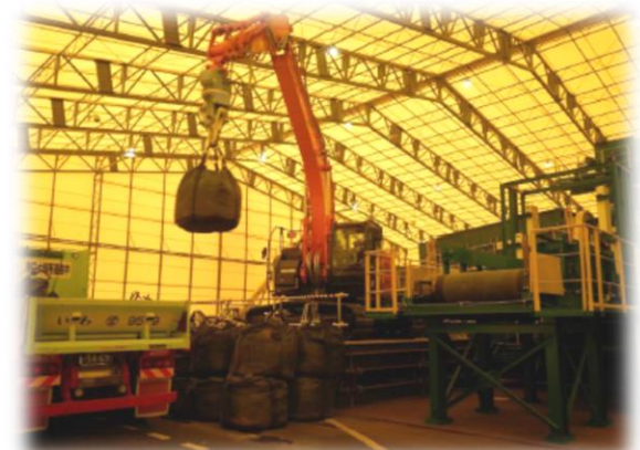
受入・分別施設（1期双葉工区）
