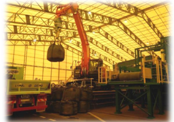
受入・分別施設（1期双葉工区）
