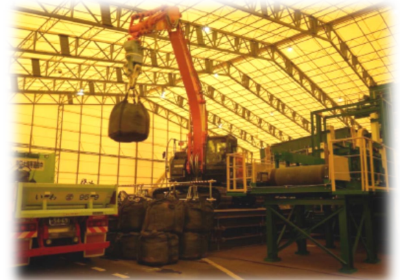
受入・分別施設（1期双葉工区）
