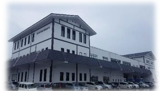
原釜荷捌き施設（相馬市）
