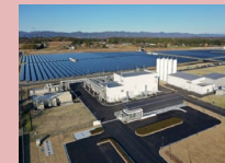
水素エネルギーネットワーク（水素製造施設）
