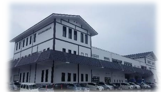
原釜荷捌き施設（相馬市）
