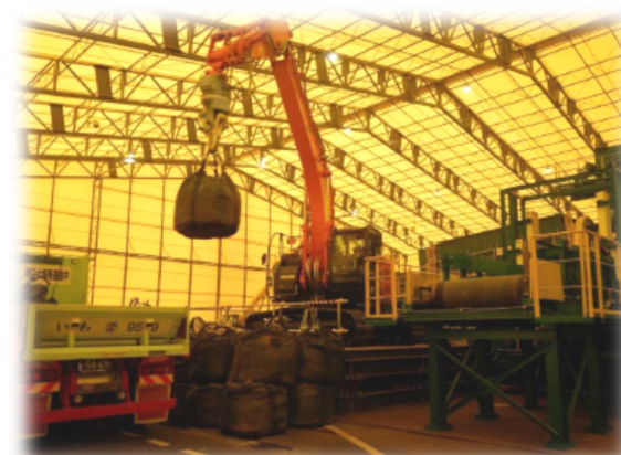
受入・分別施設（1期双葉工区）
