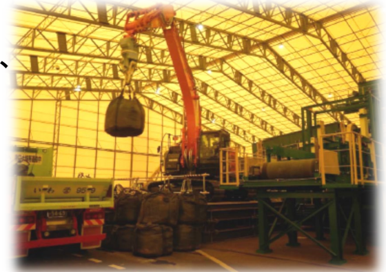
受入・分別施設(1期双葉工区)
