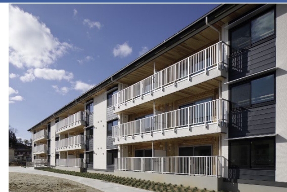
復興公営住宅（いわき市）
