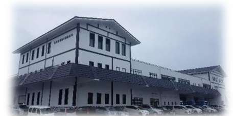
原釜荷捌き施設(相馬市)
