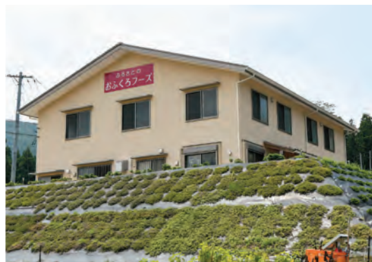
2017年に完成した新工場
