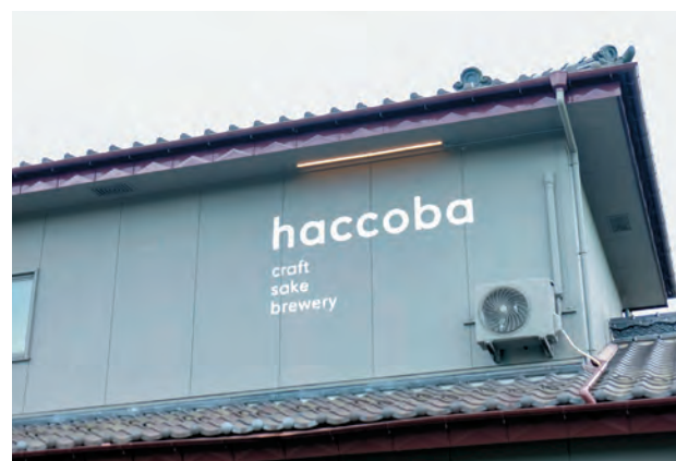
外壁にはhaccobaのロゴが輝いている
