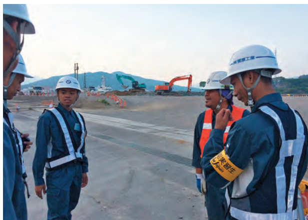
菅原工業は2015年、インドネシアに合弁会社を設立。道路整備を行っている
