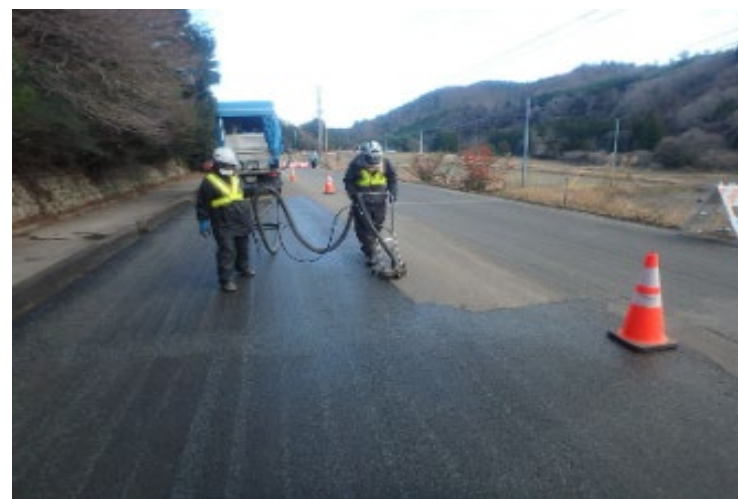
道路除染（吸引式水高圧水洗浄機） 浪江町 小丸行政区
