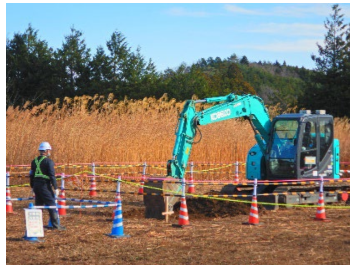
農地除染（表土の剥ぎ取り） 大熊町 下野上一区
