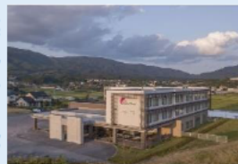
宿泊施設外観 (陸前高田市)
