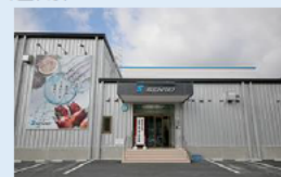
水産加工場外観 (女川町)
