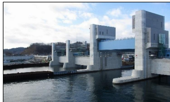
閉伊川水門（宮古市）令和8年1月撮影
