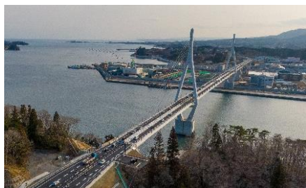
三陸沿岸道路 (気仙沼港～唐桑半島)
