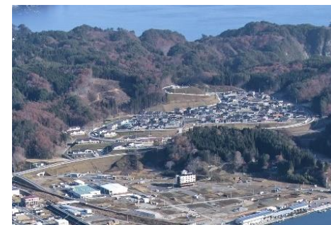
岩手県宮古市（田老地区）の高台移転
